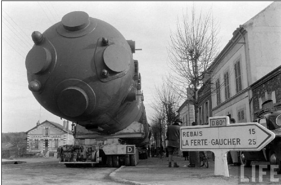
Transport de la cuve de la pile Zoé vers le Fort de Chatillon (CEA Fontenay-aux-Roses)
